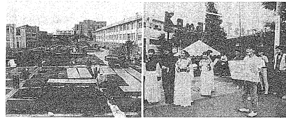
新本館工事。広いキャンパスが二分された。平成3年秋
